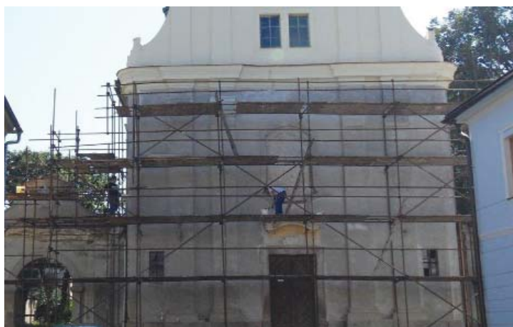
oprava fasády na čelní straně kostela
