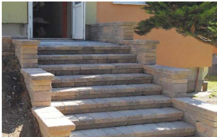
nové schodiště u jídelny ZŠ
