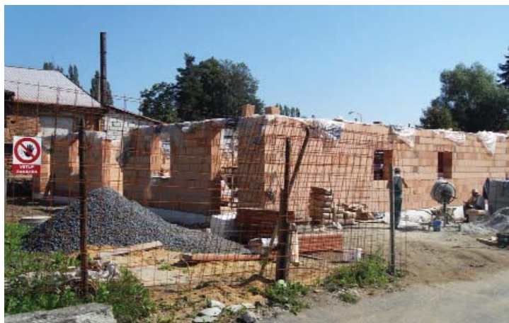
výstavba nového domu s pečovatelskou službou ve Školní ulici
